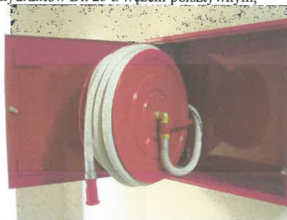
Przykład hydrantu wewnętrznego Dn 25 z węzem półsztywnym
